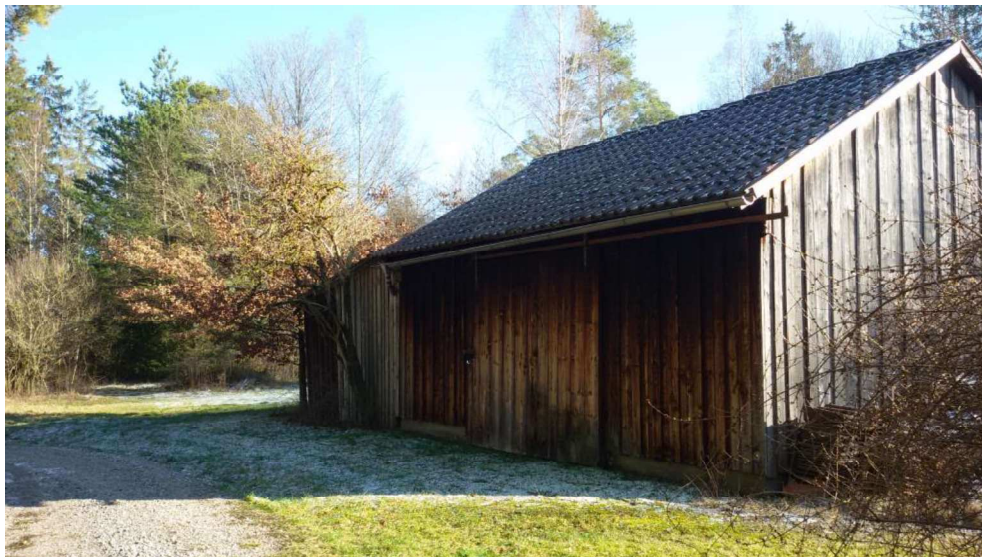
Scheune: Blick von Westen
